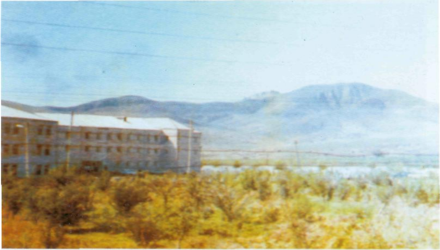
M.Mehdizadə adına məktəbin yeni tikilmiş binası
