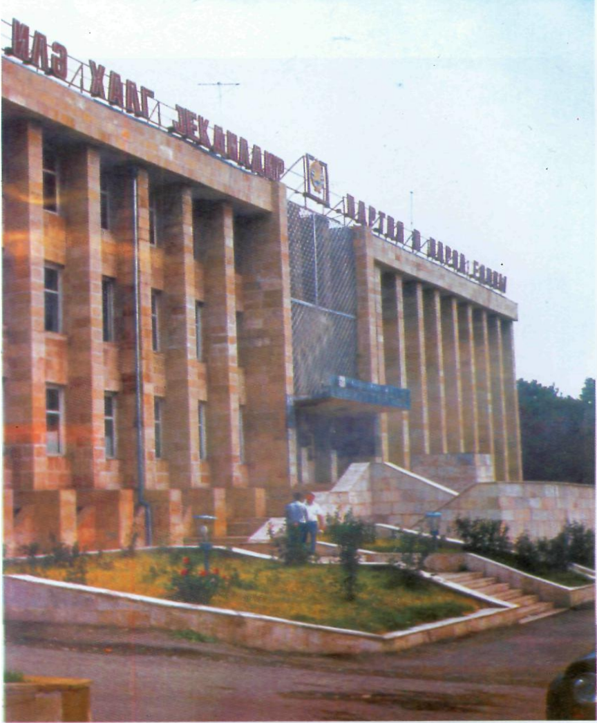
Cəbrayıl Rayon İcra Hakimiyyətinin inzibati binası
